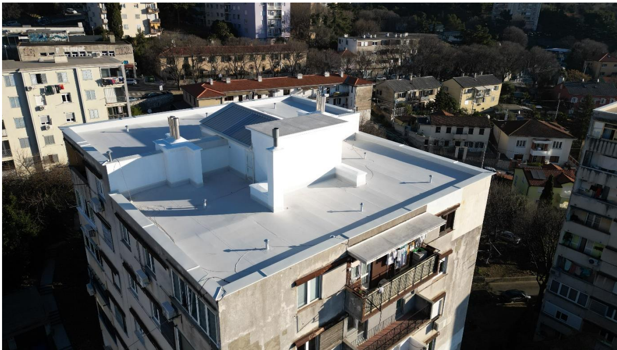
EO Šibenska 5, Rijeka Fotografije krova nakon izvedenih radova sanacije
